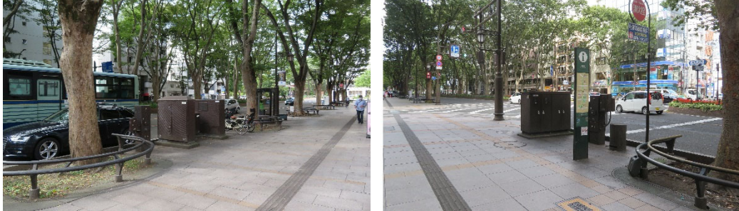
図 地上機器の設置状況
